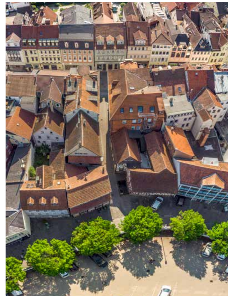
Hier geht die Sanierung in den kommenden Jahren weiter
