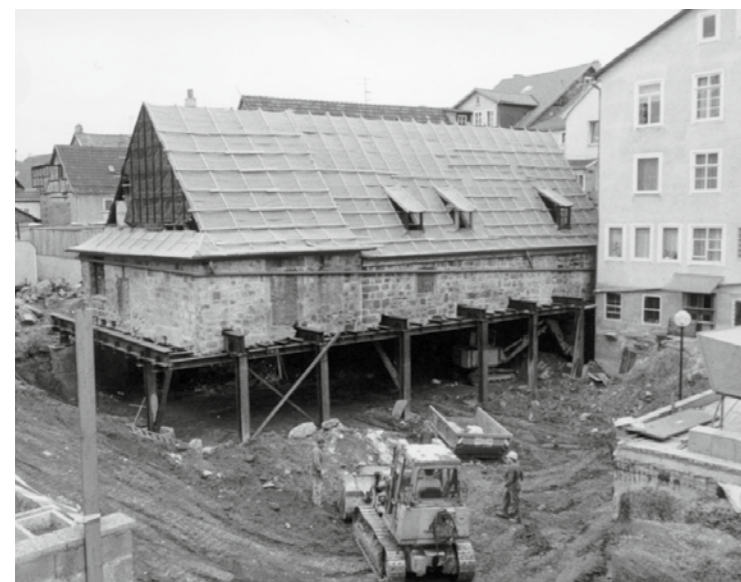
Kreative Lösungen waren beim Bau der Tiefgarage unter dem ehemaligen Brauhaus gefragt
