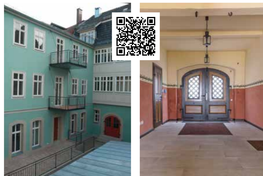
Denkmalgerechte Sanierung alter Gebäude im Steinweg
