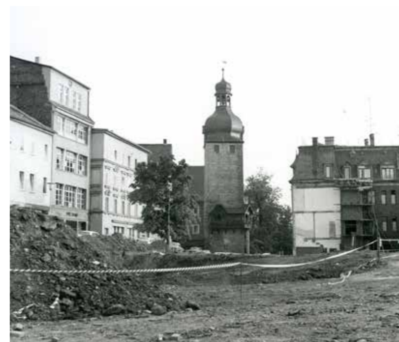
Auf der ehemaligen Stadtmauer entstand das Parkhaus Mauer
