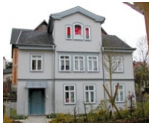
Baudenkmal um 1850, umgebautes und saniertes Biedermeierhaus mit drei Wohnungen, fertig gestellt 1999.
