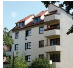
Neubau des Wohngebäudes mit fünf Wohnungen, fertig gestellt 1985.
