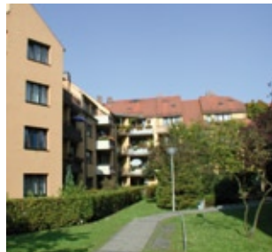
Neubau der Wohngebäude mit 24 Wohnungen, Hof mit Freifläche, Tiefgarage (49 Stellplätze), fertig gestellt 1982.
