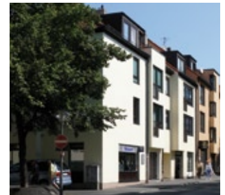
Neubau des Wohngebäudes mit drei Wohnungen und einer Gewerbefläche, fertig gestellt 1982.
