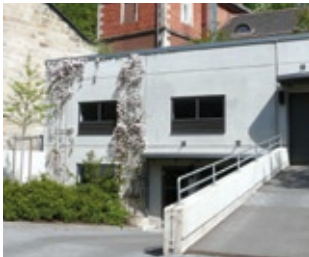
Neubau einer Gemeinschaftsgarage mit 30 Stellplätzen, fertig gestellt November 2005.
