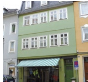
Baudenkmal 18. Jhd., saniertes Wohn- und Geschäftshaus, eine Gewerbefläche und fünf Wohnungen, fertig gestellt 1994.
