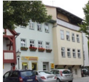
Baudenkmäler 16/17. Jhd., ehemalige Gerberhäuser, saniert und umgebaut zu Wohn- und Geschäftshäusern, zwei Gewerbeflächen, drei Wohnungen, fertig gestellt 1996.
