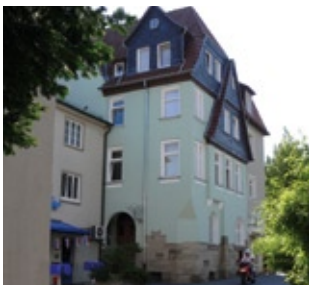
Anbau und Sanierung des Wohngebäudes (um 1900) mit acht Wohnungen, fertig gestellt 1980.
