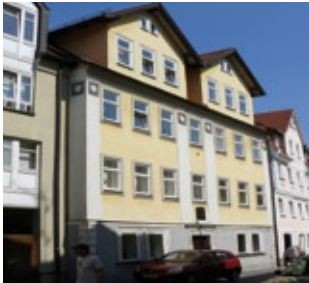
Baudenkmal Mitte 18. Jhd., umgebautes, saniertes Mehrfamilienwohnhaus mit fünf Wohnungen, fertig gestellt 1989.
