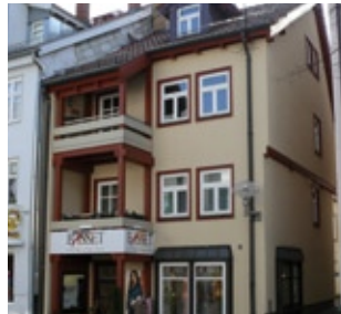
Sanierung des Wohn- und Geschäftshauses (17. Jhd.) mit zwei Wohnungen und einer Gewerbefläche, fertig gestellt 1981.
