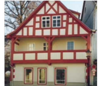
Baudenkmal von 1618, ehemaliges Gerberhaus, saniert und umgebaut zu einem Wohn- und Geschäftshaus, eine Gewerbefläche und drei Wohnungen, fertig gestellt 1992.
